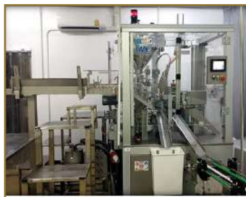
ก่อสร้างสายการผลิตแยมหลอด และติดตั้งเครื่องบรรจุแยมหลอด
