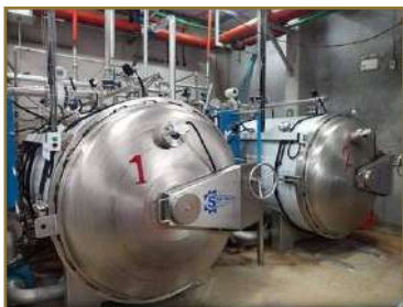
ติดตั้ง Water Spray Retort
